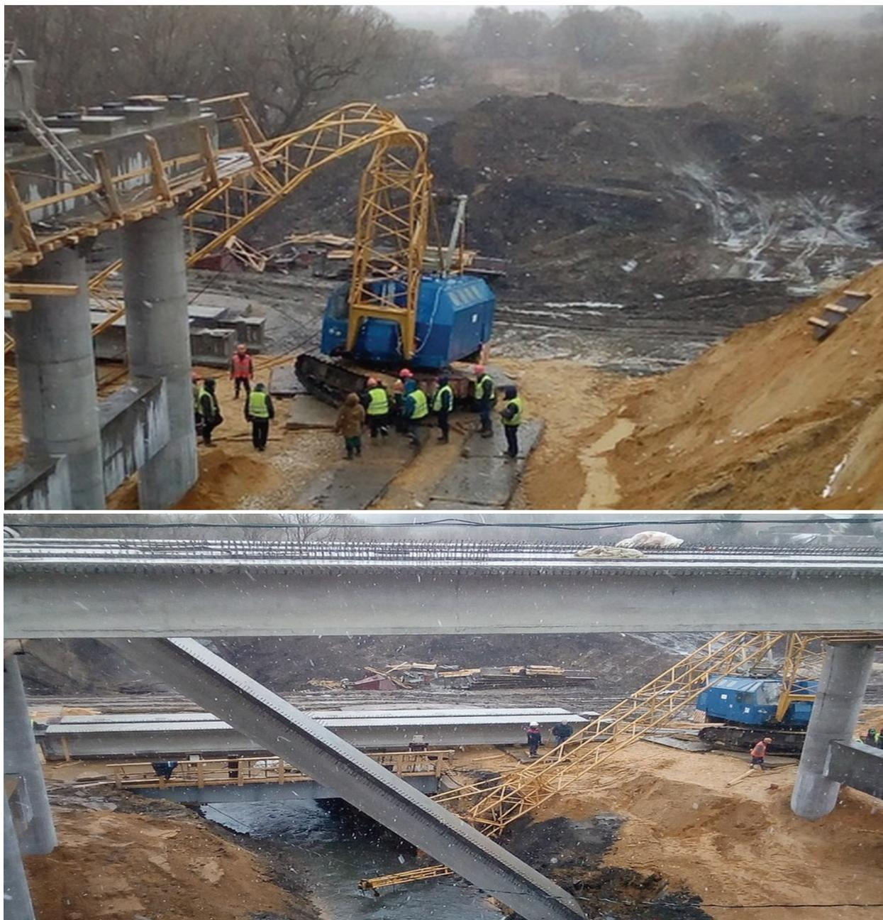
**Рис. 52.** Место падения опалубки при производстве погрузо-разгрузочных работ в д. Красное Гремячево
