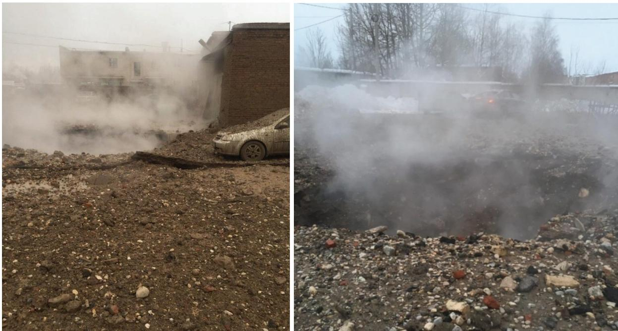
**Рис. 37.** Результаты взрыва паропровода насыщенного пара диаметром 426 мм в г. Смоленске
