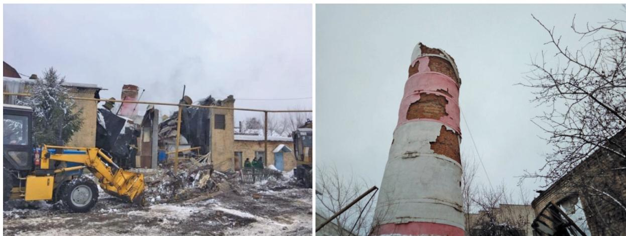
**Рис. 38.** Результаты обрушения верхней части ствола дымовой трубы в г. Воронеж
